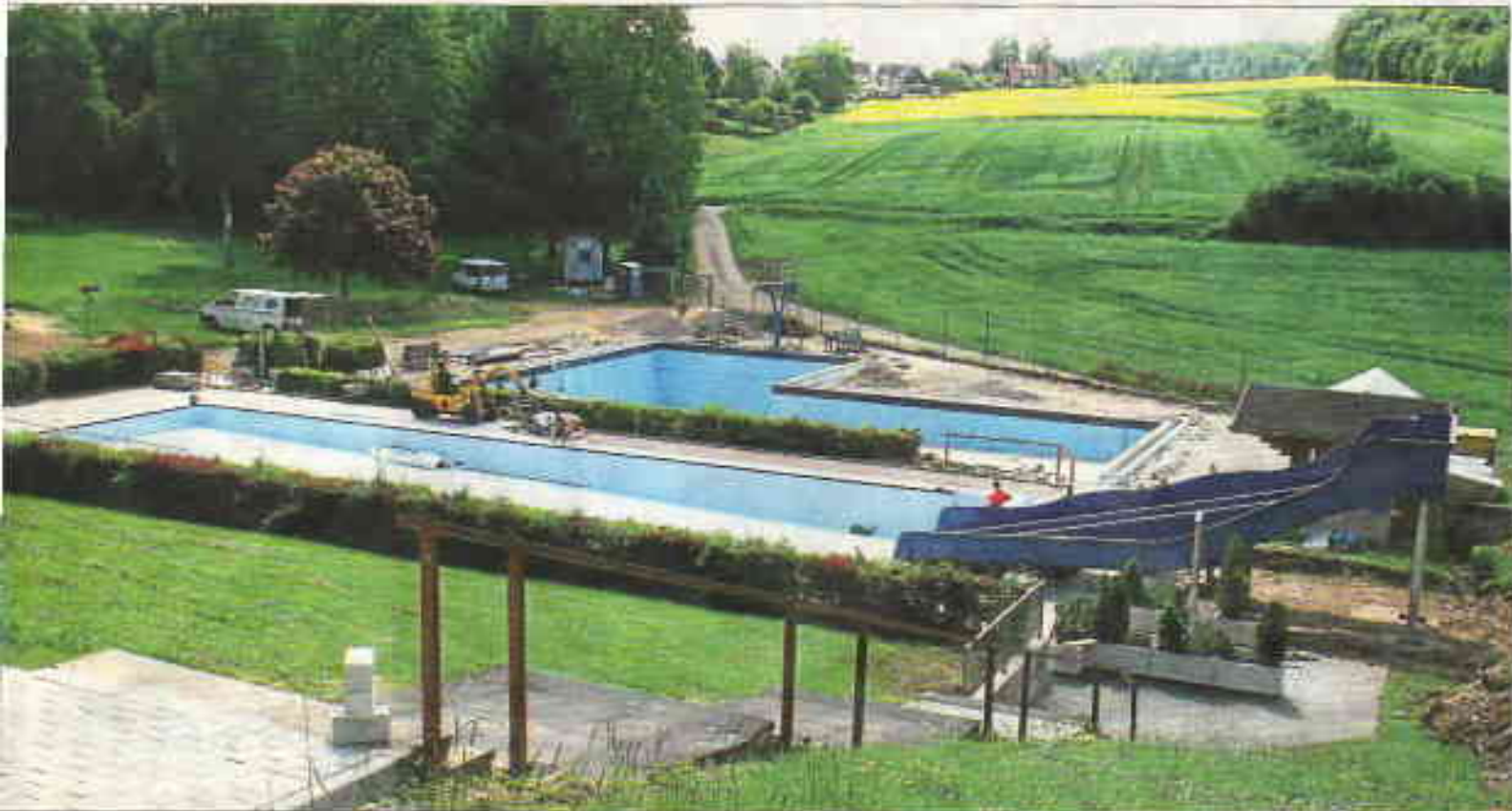
Immer noch Baustelle: Das Freibad Birlenbach mit neuer Rutsche (rechts).
